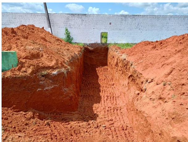
FOTO 1: Escavação Mecanizada
