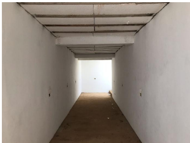
FOTO 15: Estrutura em Concreto e Pintura
