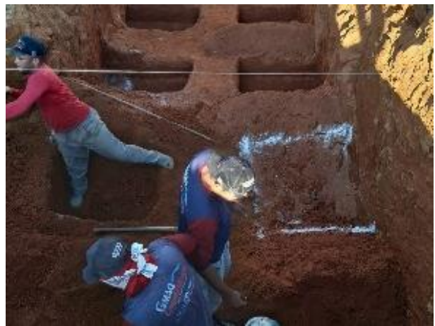
FOTO 2: Escavação Para Sapatas
