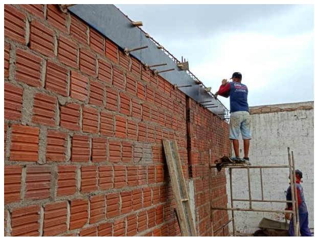
FOTO 4: Estruturas e Alvenarias
