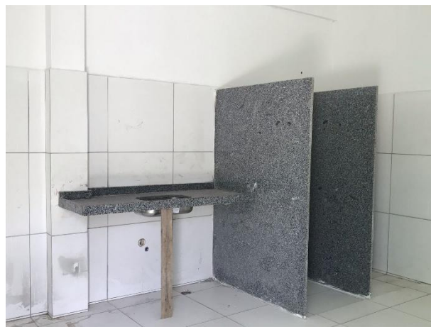
FOTO 18: Bancada e Divisórias em Granito
