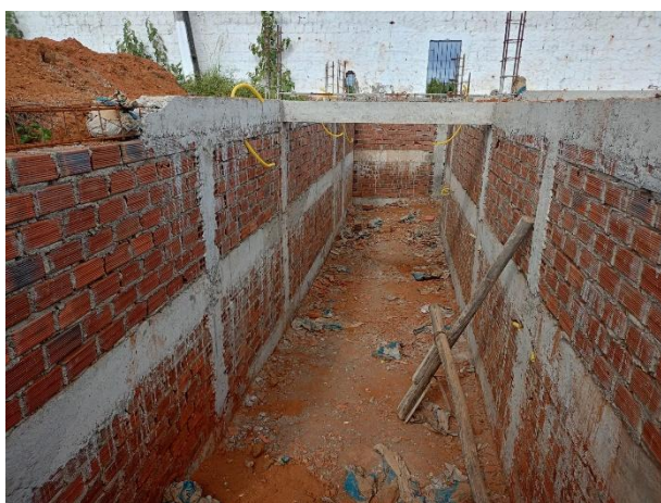
FOTO 3: Estruturas e Alvenarias
