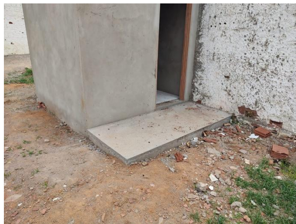
FOTO 8: Piso, Alvenaria, Massa única
