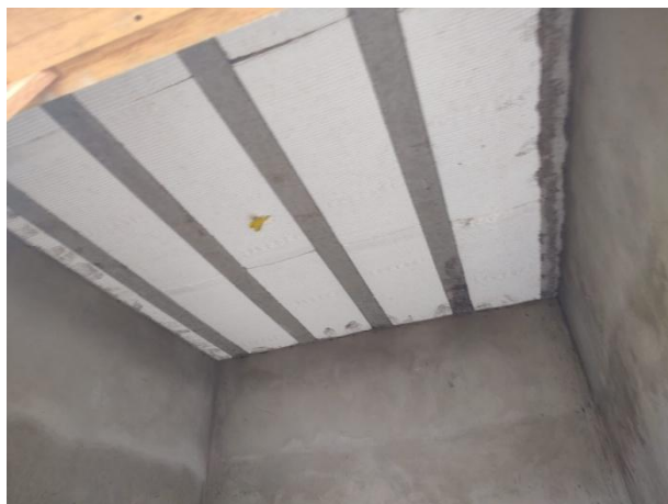
FOTO 7: Laje pré-moldada
