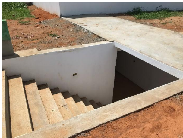
FOTO 16: Escadas Acesso ao Vestiário
