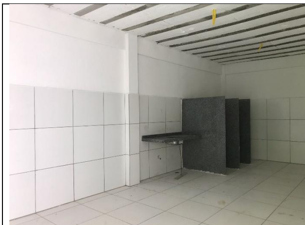
FOTO 19: Bancada e Divisórias em Granito
